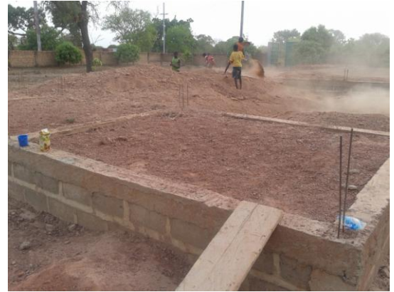
et premières fondations
