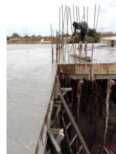
la dalle de l'étage est coulée en attente de la maçonnerie!
